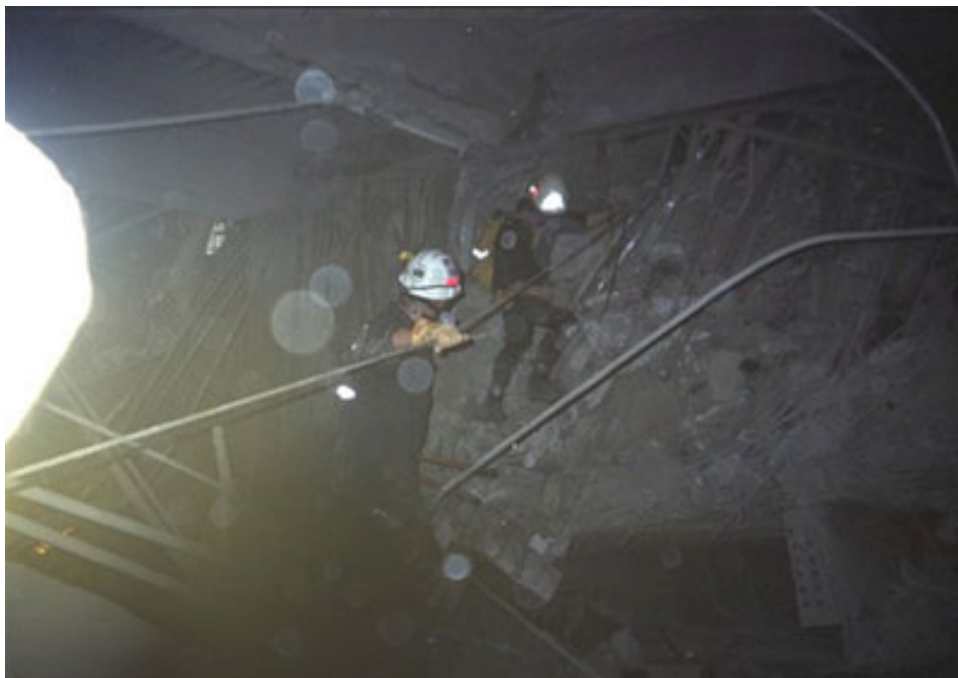
In avvicinamento all'ingresso del sottilivello dell'Edificio 6.
